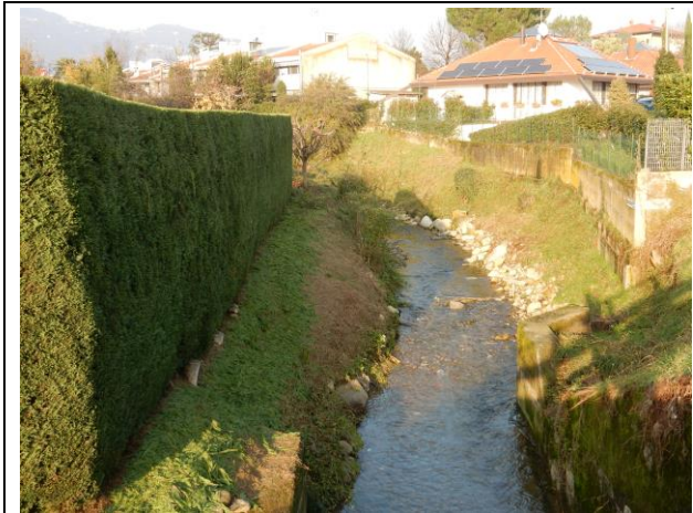
Foto 1: Alveo del Torrente Dordo
