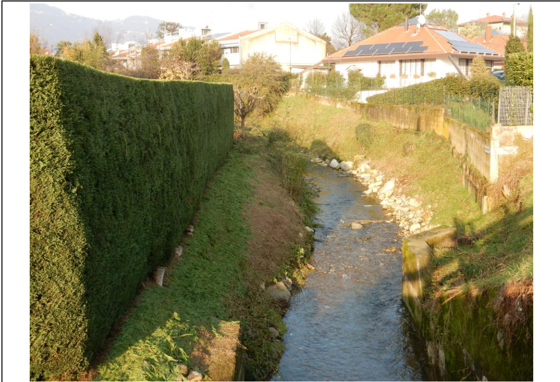
Foto 1: tratto del torrente Dordo nell'abitato del Comune di Ambivere
