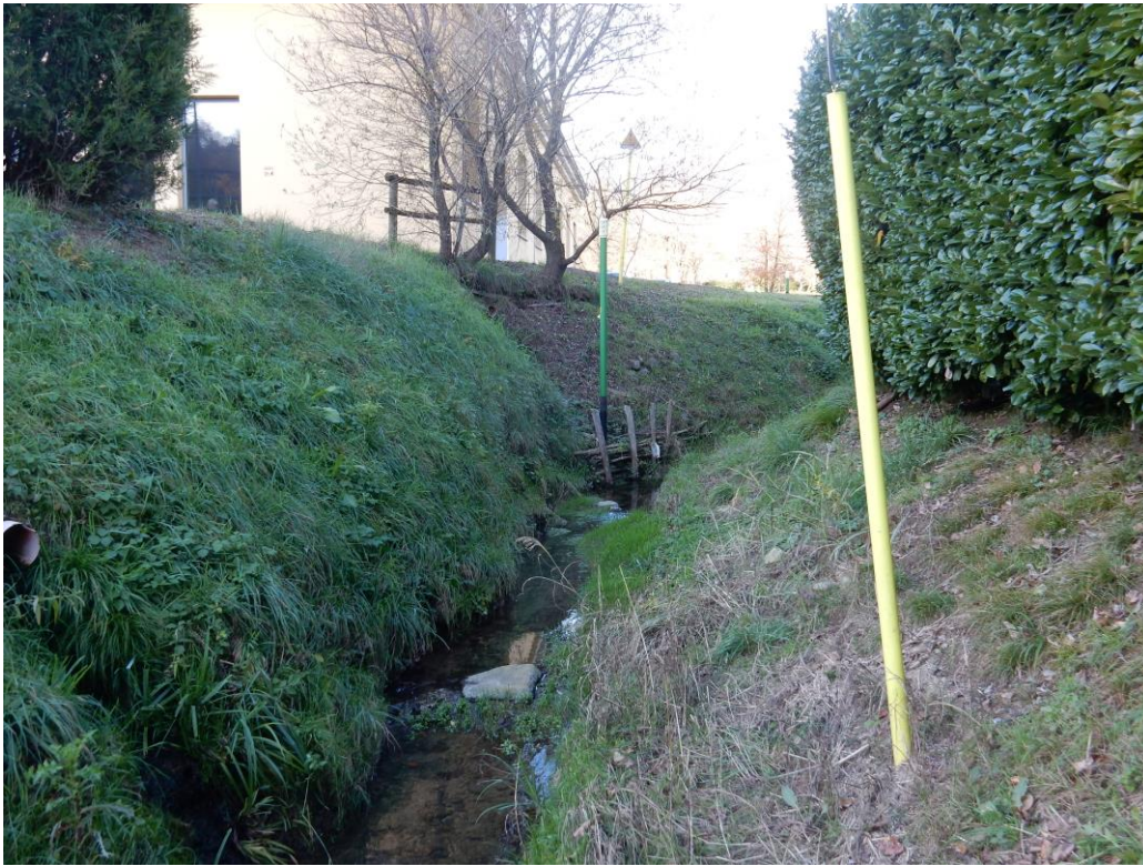
Foto 9: alveo del Torrente Cargello all'interno del centro abitato
