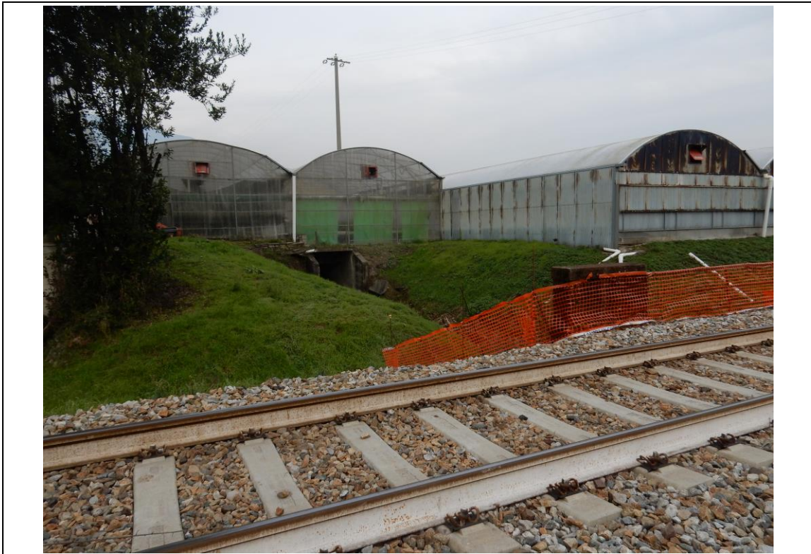
Foto 13: parte terminale del tratto tombinato del corso "Val Mora"
