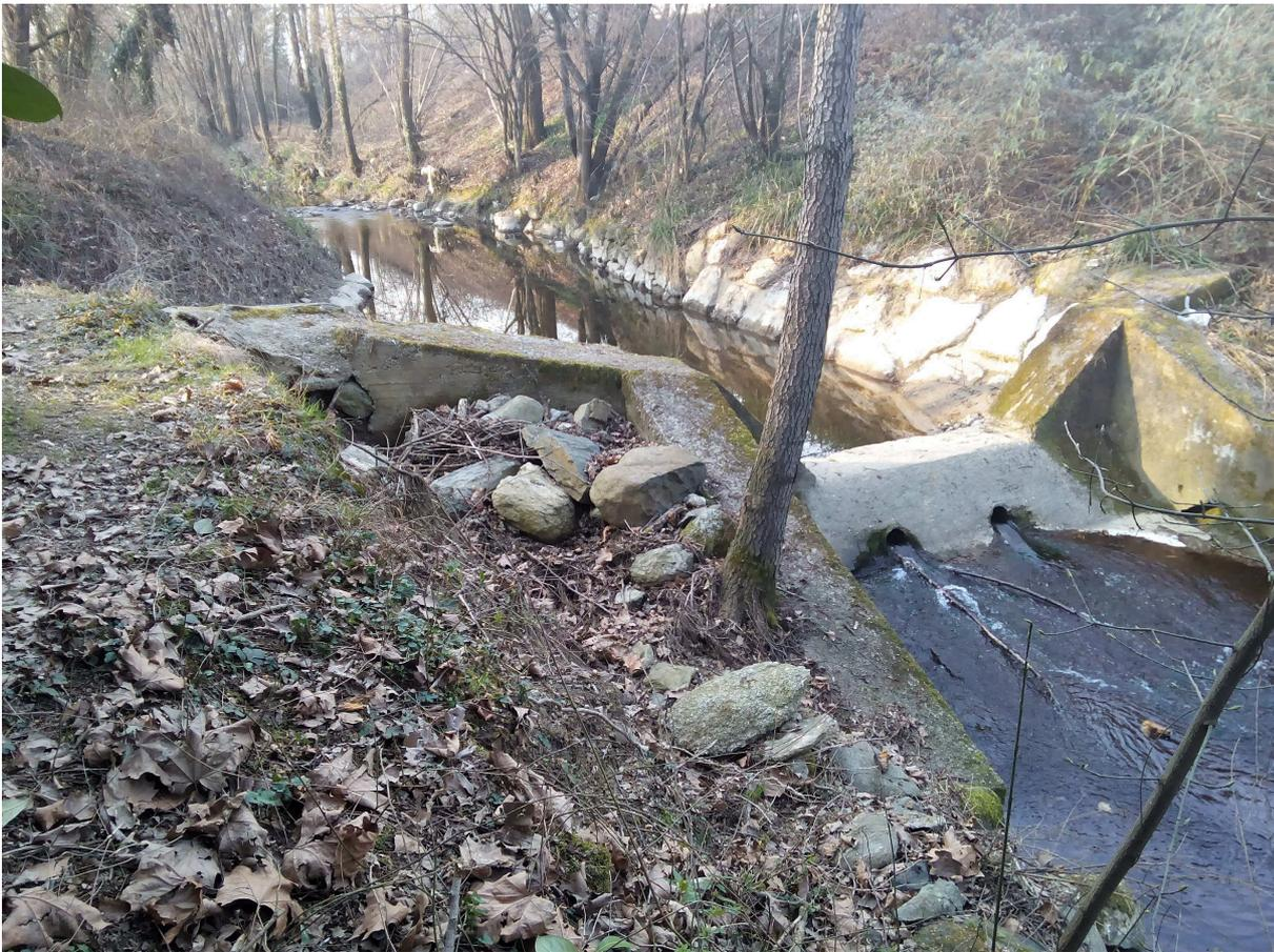
La pendenza dell'alveo principale (lungo il tracciato del diversivo) varia mediamente dal 7‰ al 1-2‰. Va rilevato che pur disponendo originariamente di sezioni abbastanza ampie nei suddetti diversivi, con l'estendersi del tessuto urbano, queste sono state mortificate da innumerevoli ponti, i cui impalcati sottostanti il piano stradale riducono le sezioni libere mediamente di 1,00+1,30 m.
