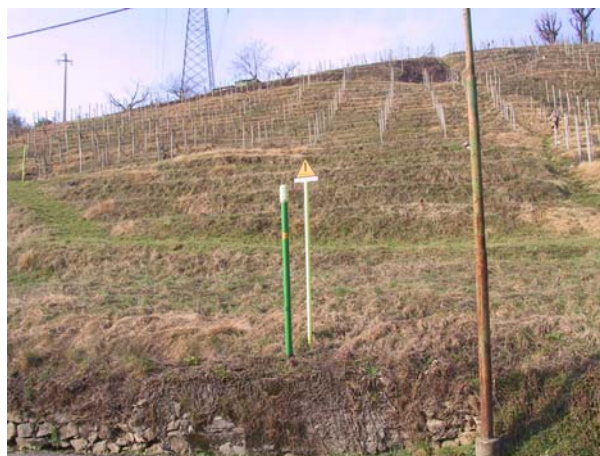
Foto 14: Palo di segnalazione del metanodotto SNAM in via Kennedy.
