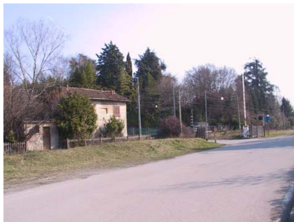
Foto 6: Attraversamento della linea ferroviaria in località Cerchiera.
