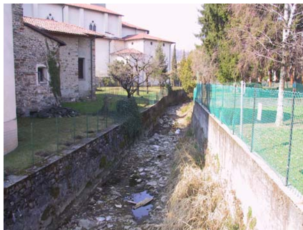
Foto 2: Torrente Dordo in corrispondenza dell'attraversamento di via Battisti.
