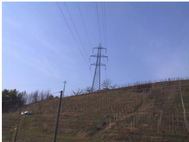
Foto 9: Linee ad Alta Tensione AAL211 e AAL 222 in corrispondenza di via Kennedy.
